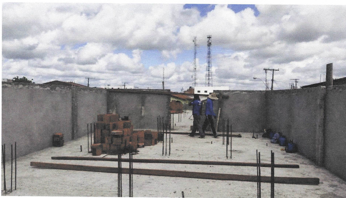
Foto 08 - ALVENARIA DE VEDAÇÃO DE BLOCOS CERÂMICOS FURADOS NA HORIZONTAL DE 9X19X19 CM (ESPESSURA 9 CM) E ARGAMASSA DE ASSENTAMENTO COM PREPARO EM BETONEIRA. AF_12/2021
