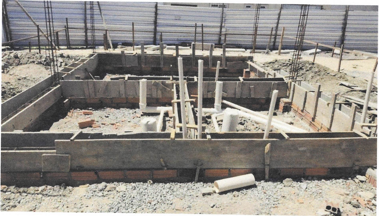
Foto 21- Ponto de esgoto com tubo de pvc rígido soldável de Ø 40 mm (lavatórios, mictórios, ralos sifonados, etc...)
