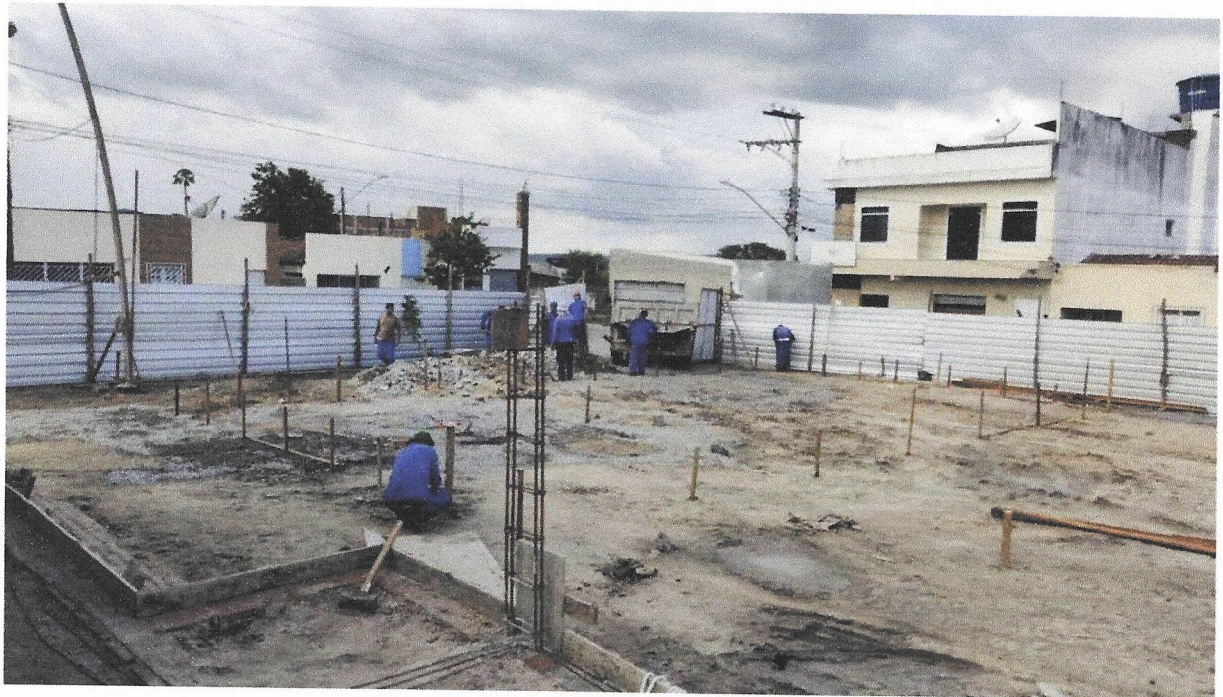
Foto 27- LIMPEZA MANUAL DE VEGETAÇÃO EM TERRENO COM ENXADA. AF_05/2018
