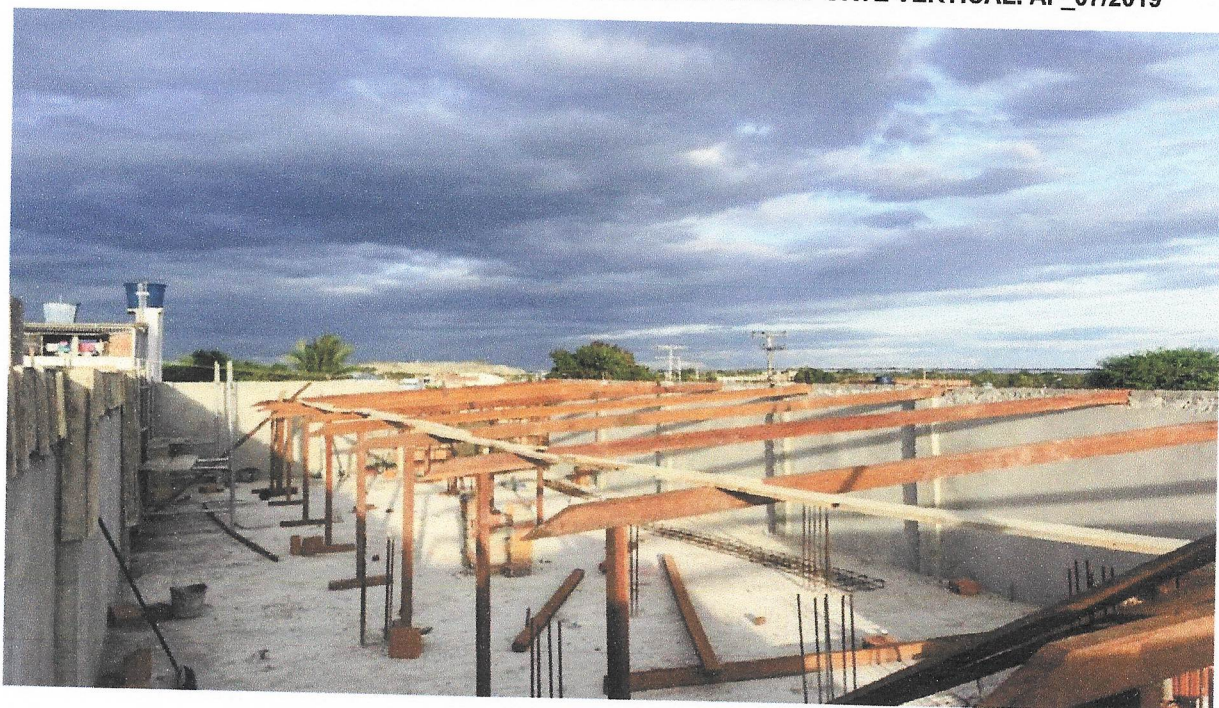
Foto 10 – TRAMA DE MADEIRA COMPOSTA POR TERÇAS PARA TELHADOS DE ATÉ 2 ÁGUAS PARA TELHA ESTRUTURAL DE FIBROCIMENTO, INCLUSO TRANSPORTE VERTICAL. AF_07/2019
