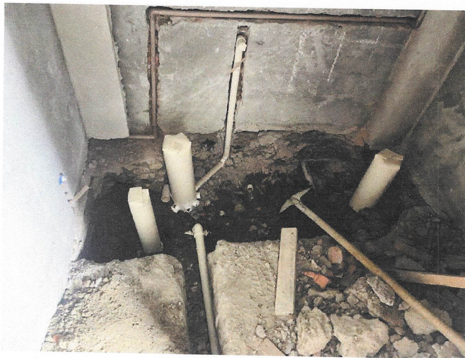
Foto 24 – INSTALAÇÃO HIDROSSANITÁRIA DO 1º PAVIMENTO
