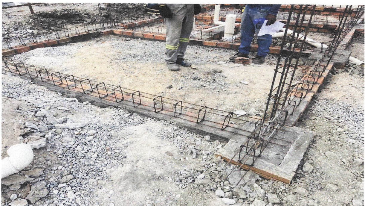
Foto 16 – (COMPOSIÇÃO REPRESENTATIVA) EXECUÇÃO DE ESTRUTURAS DE CONCRETO ARMADO, PARA EDIFICAÇÃO INSTITUCIONAL TÉRREA, FCK = 25 MPA. AF_01/2017
