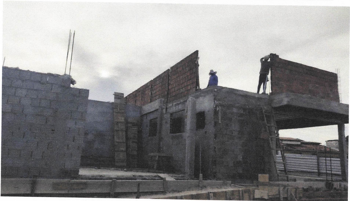
Foto 05 - ALVENARIA DE VEDAÇÃO DE BLOCOS CERÂMICOS FURADOS NA HORIZONTAL DE 9X19X19 CM (ESPESSURA 9 CM) E ARGAMASSA DE ASSENTAMENTO COM PREPARO EM BETONEIRA. AF_12/2021
