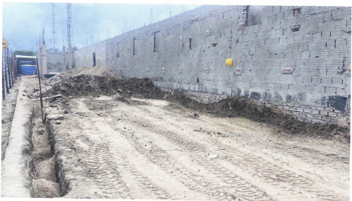
Foto 28 – LIMPEZA MANUAL DE VEGETAÇÃO EM TERRENO COM ENXADA. AF_05/2018
