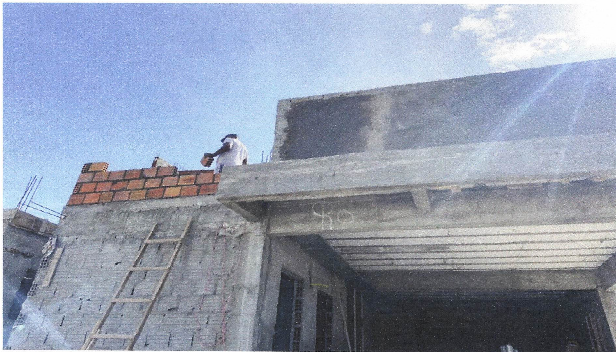
Foto 07 - ALVENARIA DE VEDAÇÃO DE BLOCOS CERÂMICOS FURADOS NA HORIZONTAL DE 9X19X19 CM (ESPESSURA 9 CM) E ARGAMASSA DE ASSENTAMENTO COM PREPARO EM BETONEIRA. AF_12/2021.
