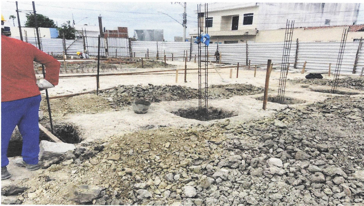
Foto 15 – (COMPOSIÇÃO REPRESENTATIVA) EXECUÇÃO DE ESTRUTURAS DE CONCRETO ARMADO, PARA EDIFICAÇÃO INSTITUCIONAL TÉRREA, FCK = 25 MPA. AF_01/2017
