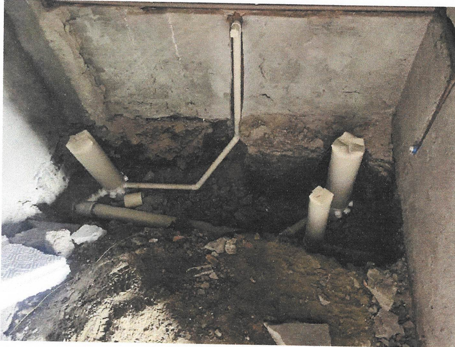
Foto 23- NSTALAÇÃO HIDROSSANITÁRIA DO 1º PAVIMENTO
